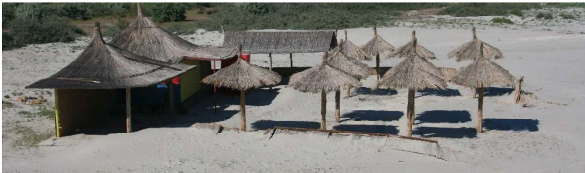
Figura 66. Acoperiș din stuf pentru construcții temporare
