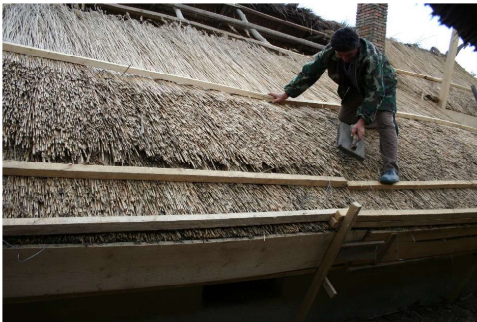
Figura 75. Finisarea unui acoperiș de stuf
