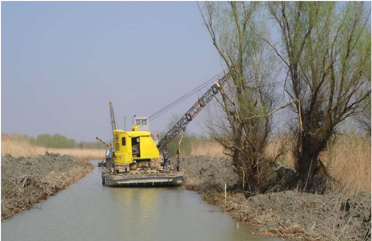
Figura 30. Lucrări hidrotehnice de întreținere a canalelor.
